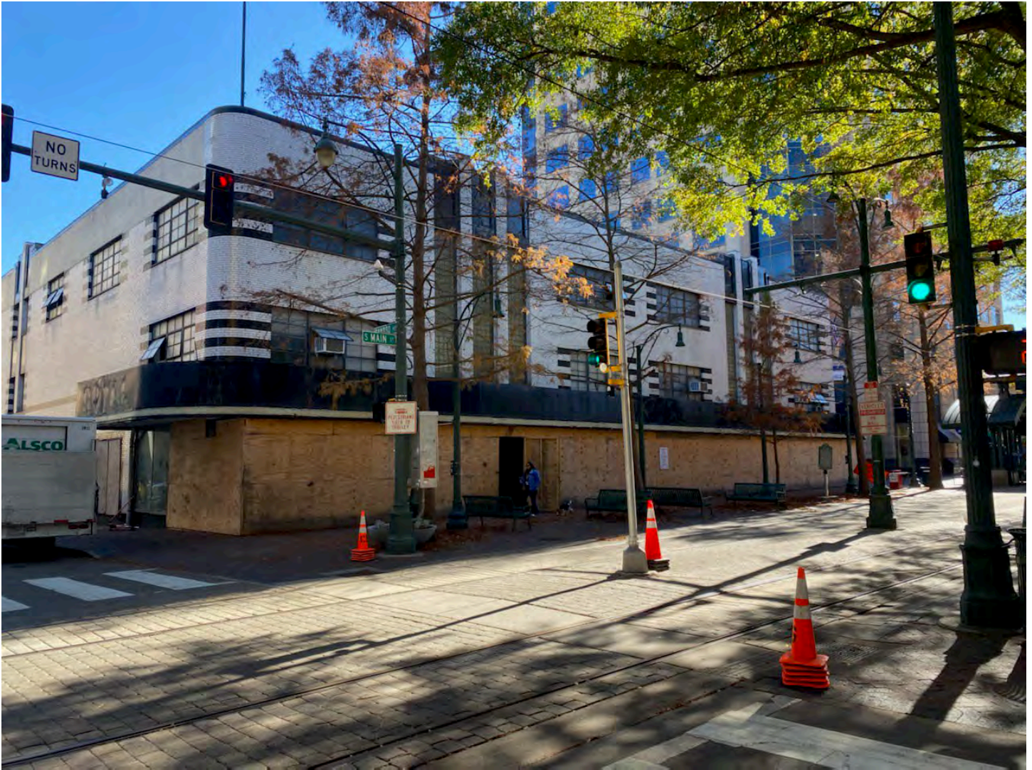
S. Main St. frontage
