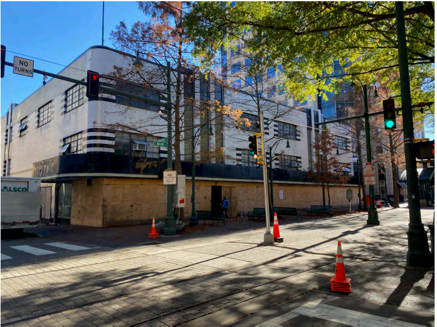
S. Main St. frontage
