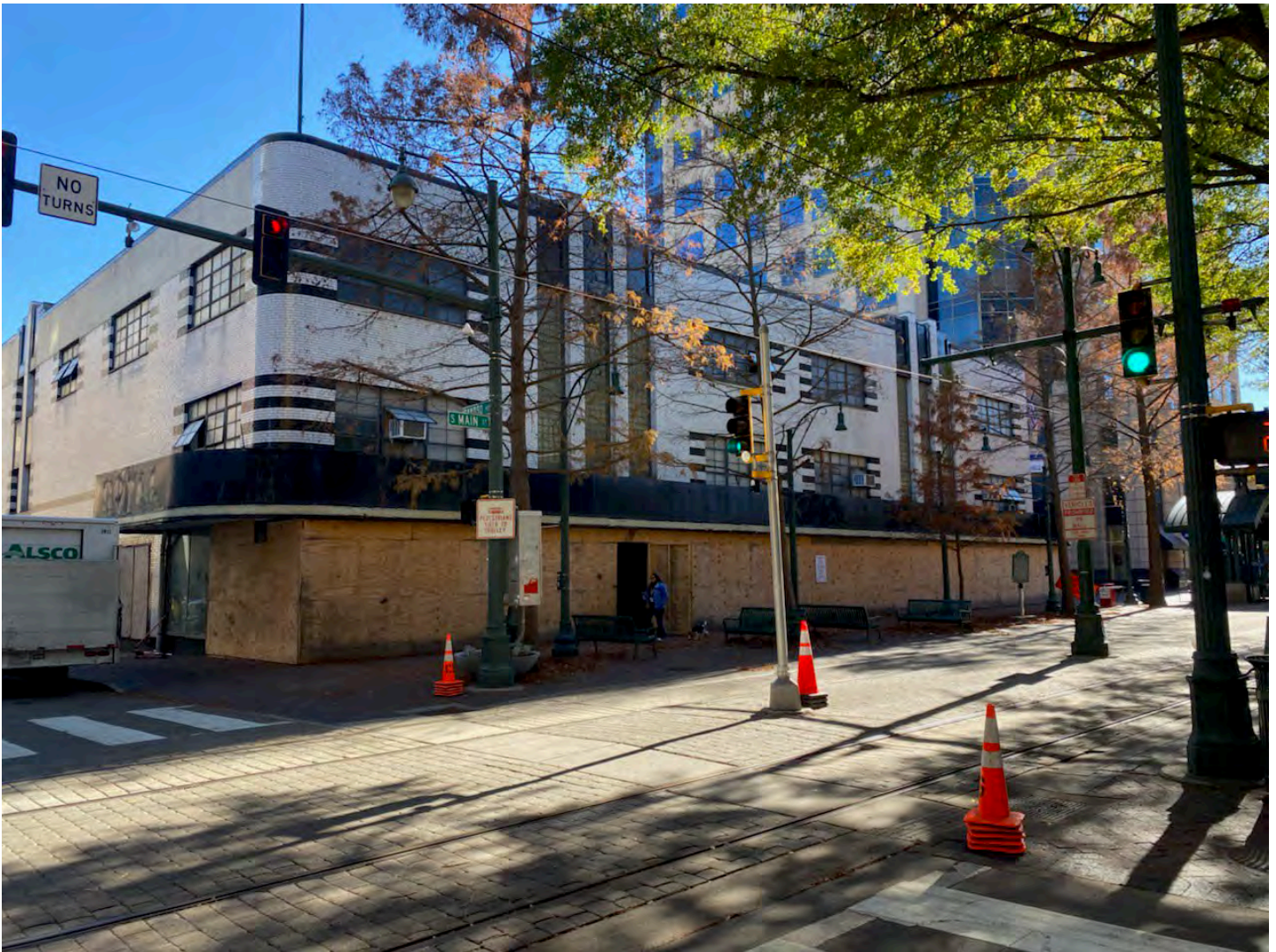
S. Main St. frontage
